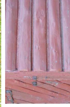
Beklædning på visse af barakkerne udføres med skaltæ - oprindelig beklædning af skaltæ er stadig intakt nogle steder (eksempel fra projektområdet)
